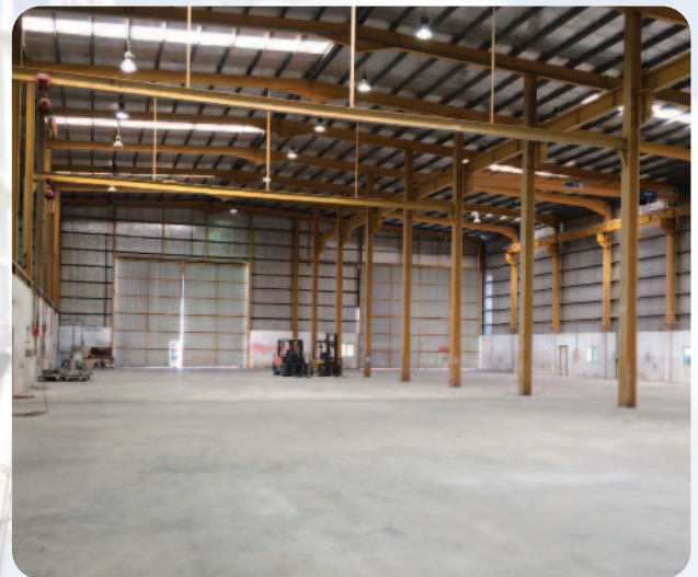
3700 sqm of fabrication shops/equipment storage تادعمل نيزخت / قيقلت ةيراجتلا تالملا نم عبرم رتم 3700
