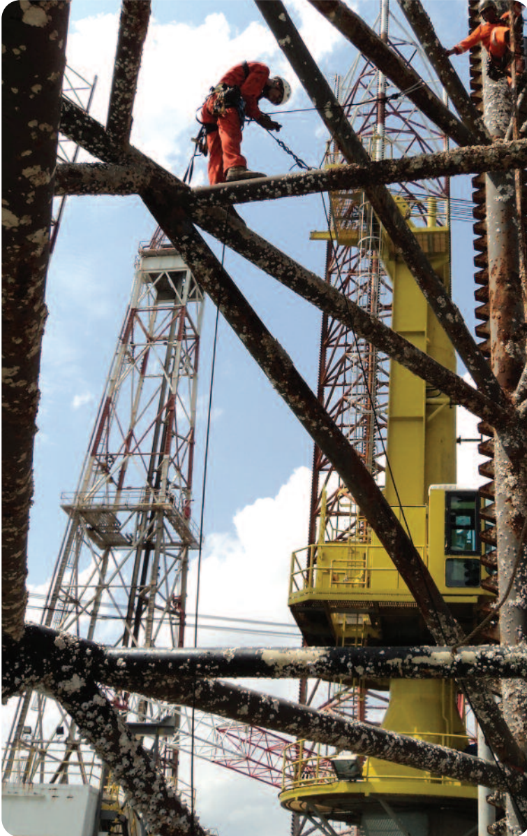
Jack Up Leg Inspection - قاسلا شيتفتلا لصري لاج
