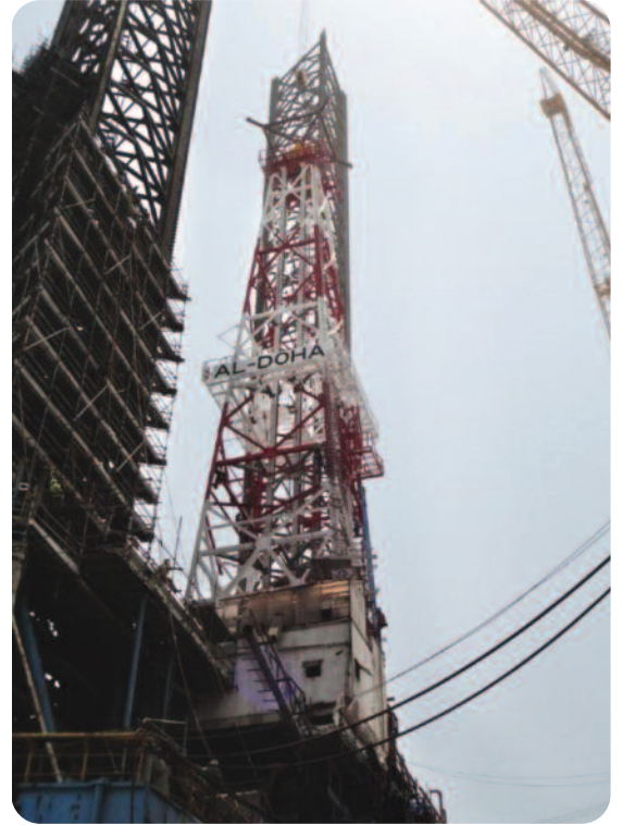
Derrick refurbishment ديجيت كيريدي
