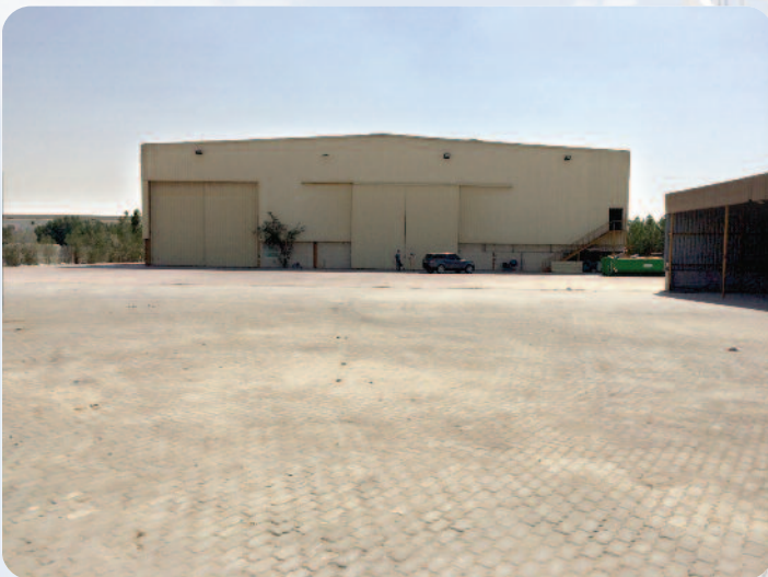
4000 sqm fabrication/rig up yard ءانفلا بكر / عبرم رتم قيقلت 4000
